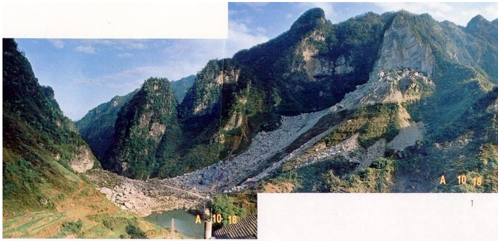
图 9 1980 年 6 月 3 日晨 5 时 35 分发生在湖北省远安县盐池河崩塌
