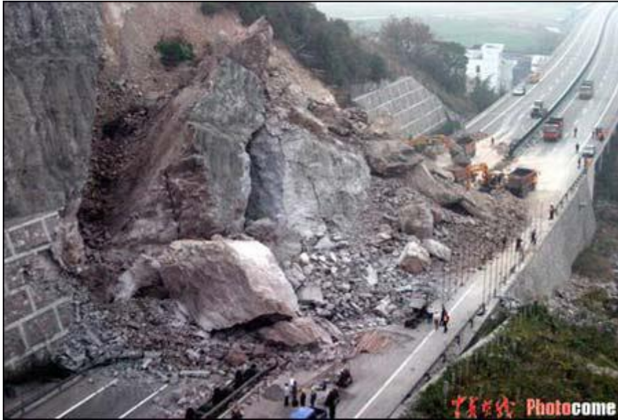
图 8 不合理加护诱发崩塌，危害交通安全
